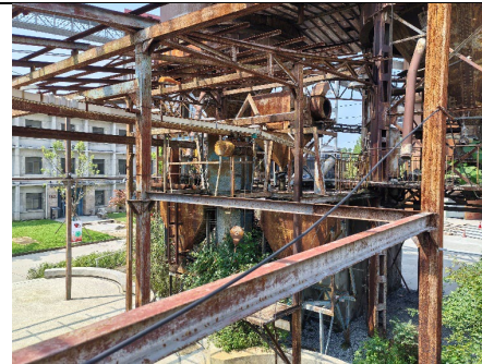
自东向西储料双罐体设备
