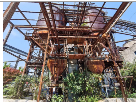
自东向西双罐体设备
