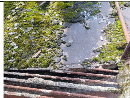
储料双罐二层钢栈道
