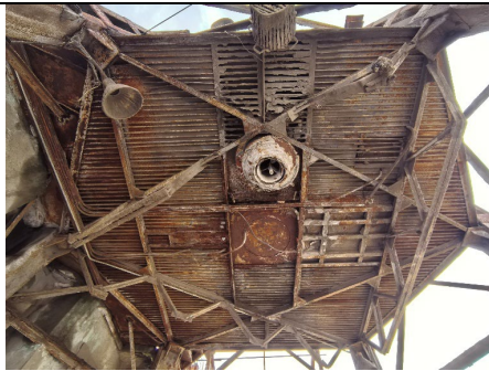
储料双罐 1 二层平台钢支撑仰视
