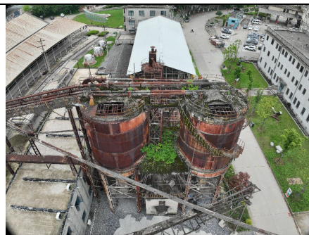
西侧储料双罐体
