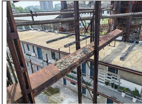
至包装车间管道
