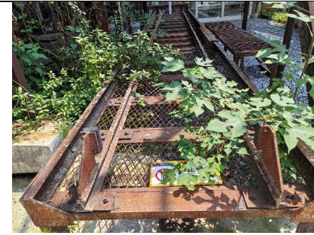
储料单罐下方传送带钢架
