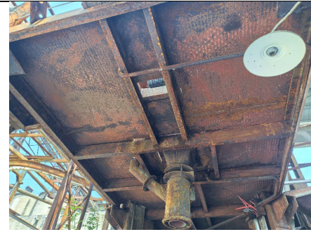
储料单罐二层钢平台支撑仰视
