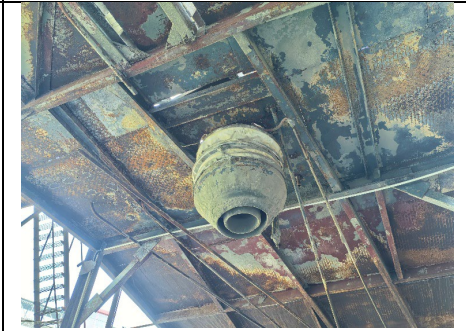
储料双罐 2 二层钢平台支撑仰视
