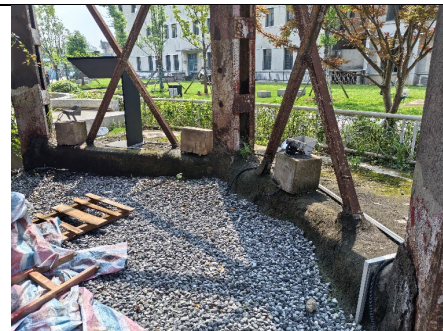
储料双罐 1 钢立柱地面现状
