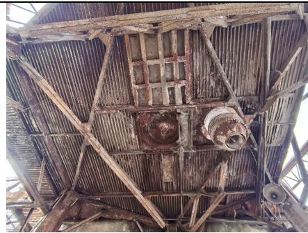
储料双罐 1 二层平台钢支撑仰视
